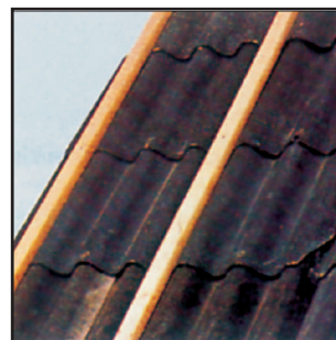
Schéma postupu laťování při pokrývání staré střechy
