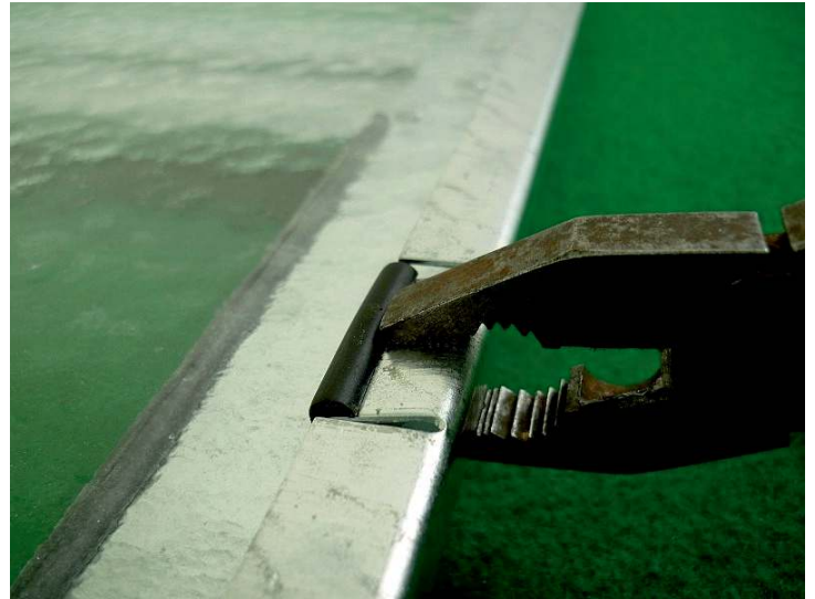
Pomocí kleští jemně přitlačíme přichytku (poz. 83-1)
