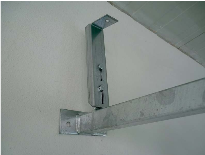
Montáž výztuhy hřebene (poz. 33) k jácklové výztuže.
