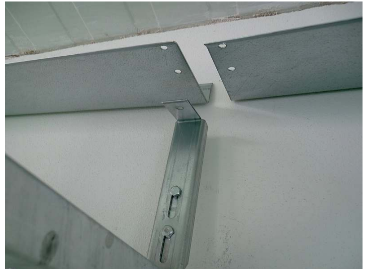
Počet hřebenových spojovacích plechů závisí na délce skleníku viz. balící list.
