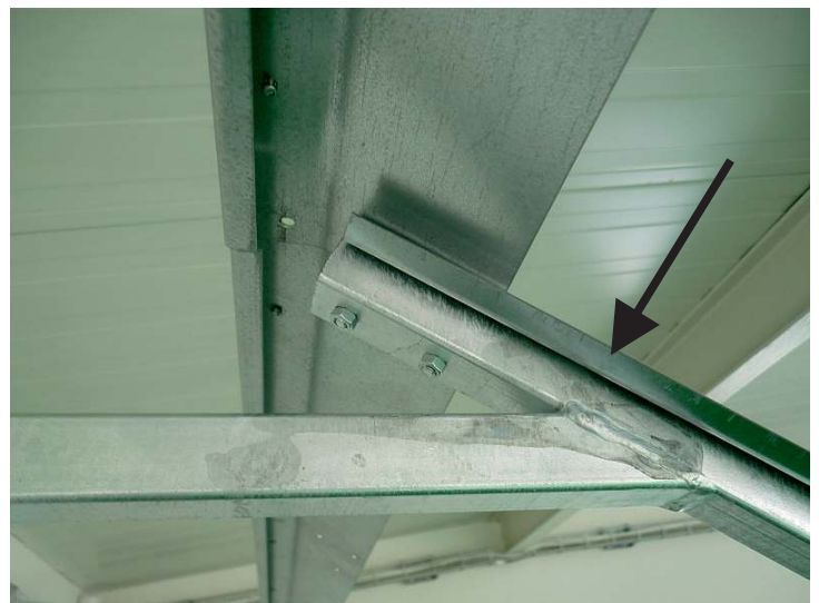
Spojovací střešní plech spojíme přes sebe s jácklovou výztuhou a sloupkem se sedmi otvory (poz.5) . Abysme později, při montáži střešních a bočních sloupků, nemuseli spoj opět rozebírat.
