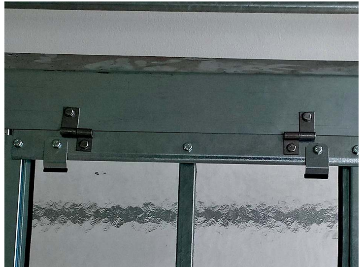
Pomocí kleští jemně přitlačíme přichytku (poz. 83-1)
