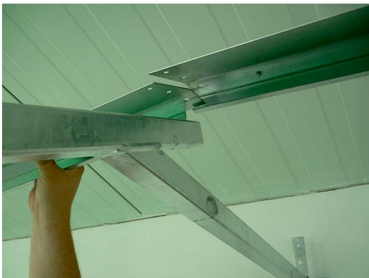
Spojovací střešní plech spojíme přes sebe s jácklovou výztuhou a sloupkem se sedmi otvory (poz.5) . Abysme později, při montáži střešních a bočních sloupků, nemuseli spoj opět rozebírat.
