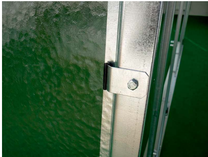
Přichycení bočního skla příchýtkou poz. 83-1
