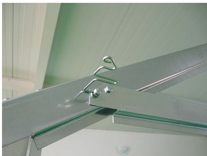
Spojení pozic 72 a 75
