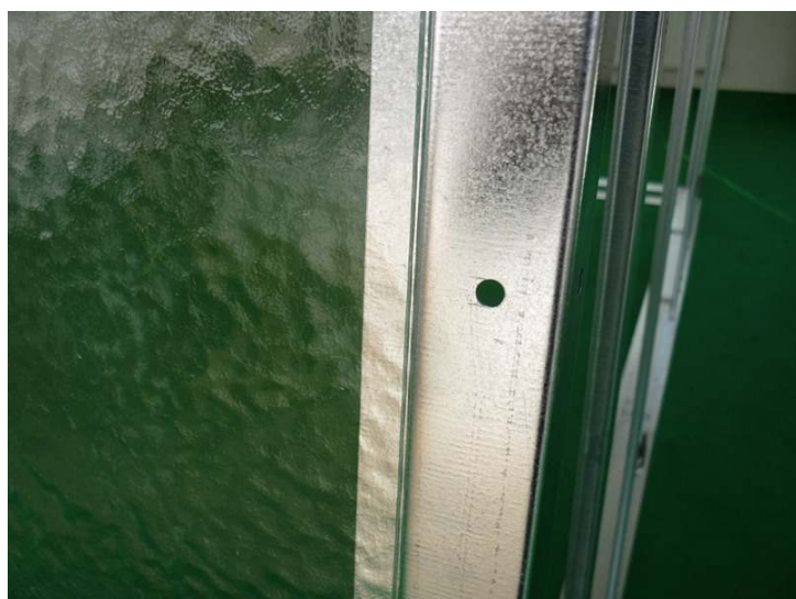
Přichycení bočního skla přičtykou poz. 83-1
