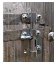
Spojovací zarážka dveří a okna
